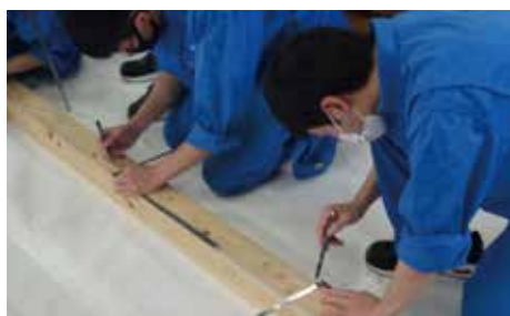
図3 原寸図から部材に寸法を写し取っているところ
