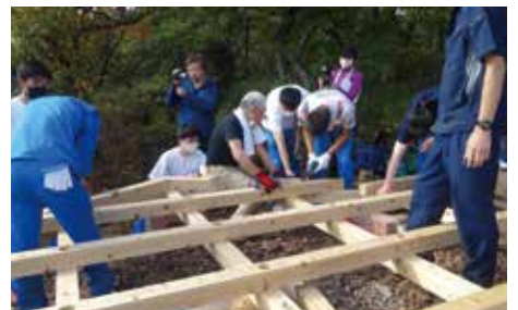
図9 現地での組み立て作業
