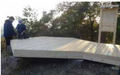
図 14 デッキを横から見たところ
