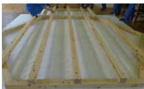
図5 原寸図の上に部材を敷きならべたところ
