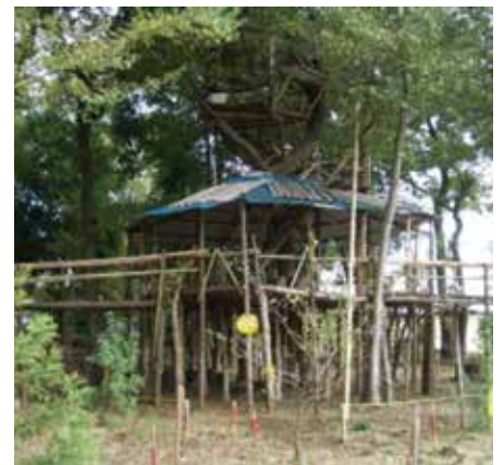
図9 1棟目のツリーハウス
