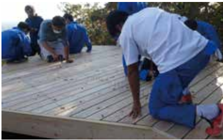
図 13 ビスの打ち込みをしているところ
