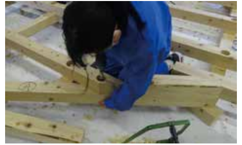
図6 ボルトで接合
