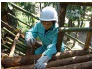
図5 3階デッキ工事
