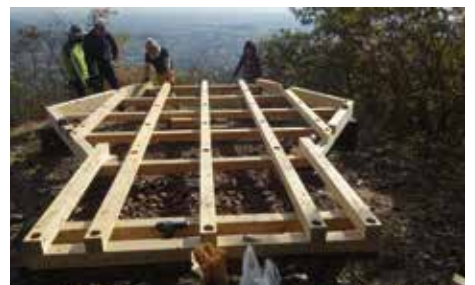
図10 現地での骨組みの完成
