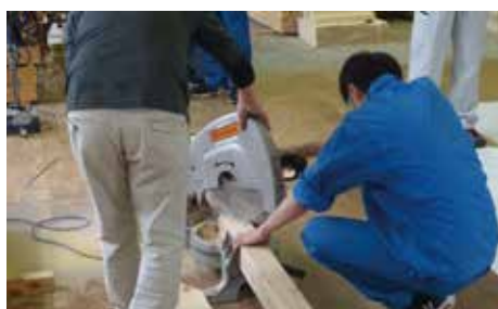
図4 電動鋸を用いて部材をカットしているところ
