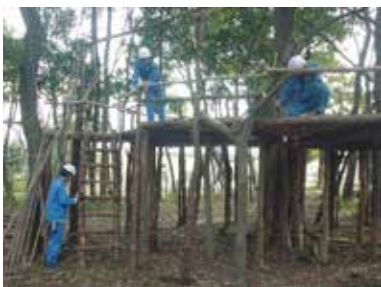
図4 階段・手摺工事
