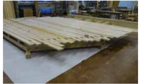
図7 デッキ材を敷きならべたところ
