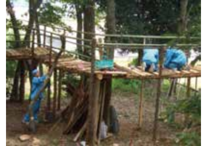
図7 空中回遊路 デッキ工事
