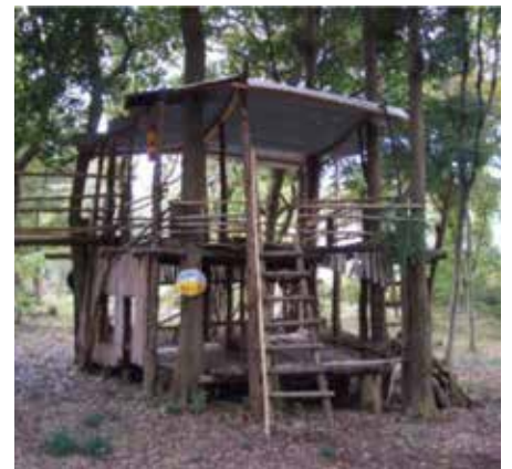
図10 2棟目のツリーハウス
