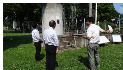
風と光の広場で水撃ポンプを見学
